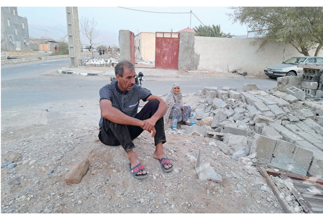
7月2日,在伊拉克南部霍尔木兹省的一个村庄,人们坐在倒塌建筑的废墟旁。伊拉克南部2日凌晨发生6.1级地震,已经造成3人死亡、19人受伤。新华社发
