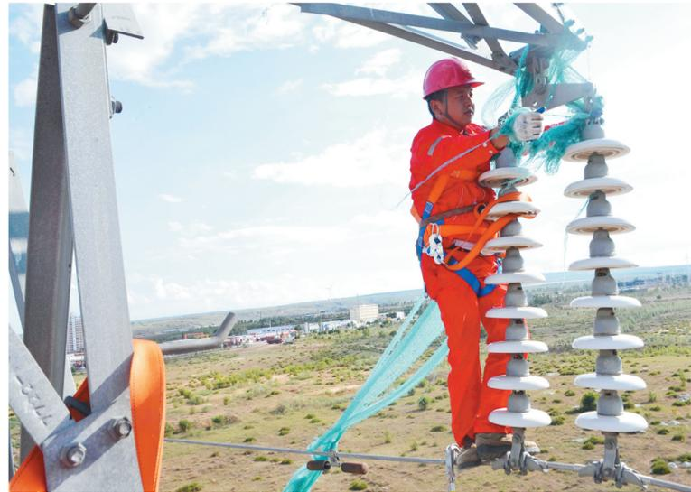
6月29日,榆林市靖边县张家畔街道因大风天气,长约6米多的防风网被吹挂在110千伏55号塔上,极易造成电力事故。管线的靖边电力大队运维一班立即停电消除隐患。图为职工手动拆除“绳结”时的情景。 □俱伟 摄
