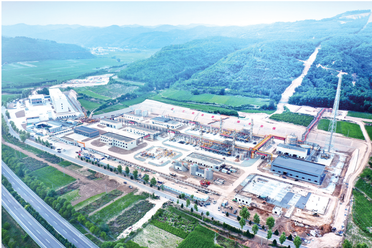
近日,航拍的陕建安集团三公司富县延694天然气地面集输EPC项目。
