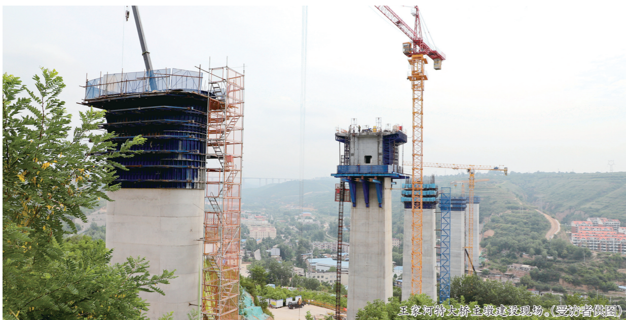
西延高铁王家河特大桥主墩建设现场。(受访者供图)
