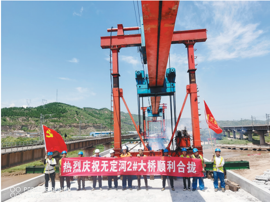
近日,由陕西国铁工程建筑有限公司承建的经北物流铁路专用线项目控制性工程——无定河2#大桥完成最后一片梁体架设后顺利合拢,标志着该项目进入了收尾冲刺阶段。
