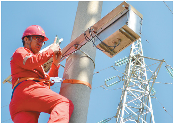
长期以来,长庆油田清浩电力公司开发项目部下大力气尝试新工艺,全力以赴保障油田生产生活用电。图为近日该公司靖边电力大队运维一班职工对新安装的35-110千伏线路故障监测系统进行检查。
