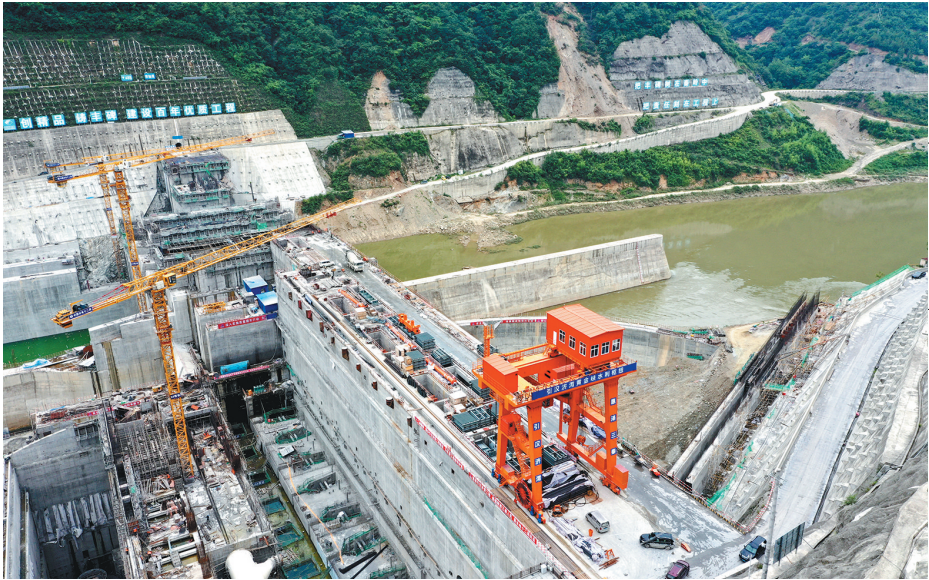
引汉济渭二期工程黄金峡水利枢纽建设现场。
