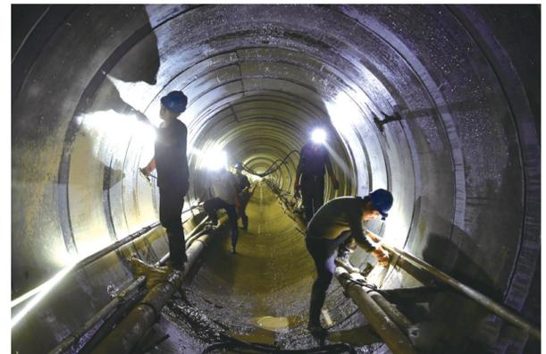
8月1日,由陕西华山路桥集团有限公司承建的西安浐灞生态区渔场路穿灞河电力隧道工程顺利贯通。该工程全长758米,隧道直径2.6米,位于地下28.6米,可改善该区域空间环境,同时解决周边用电问题。李明 摄
