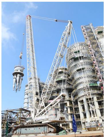
8月5日,陕西西建公司成功吊装陕西延长中煤榆林能源化工有限公司DMTO装置再生器封头及旋风系统。图为吊装现场。 陈斌 摄
