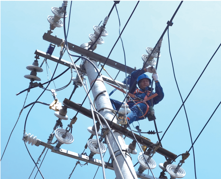
8月8日,国网洛川供电公司土基供电所员工迎着高温奋战在10千伏土百线路农网改造现场。图为职工正更换28档10千伏线路。□王晓俠 摄
