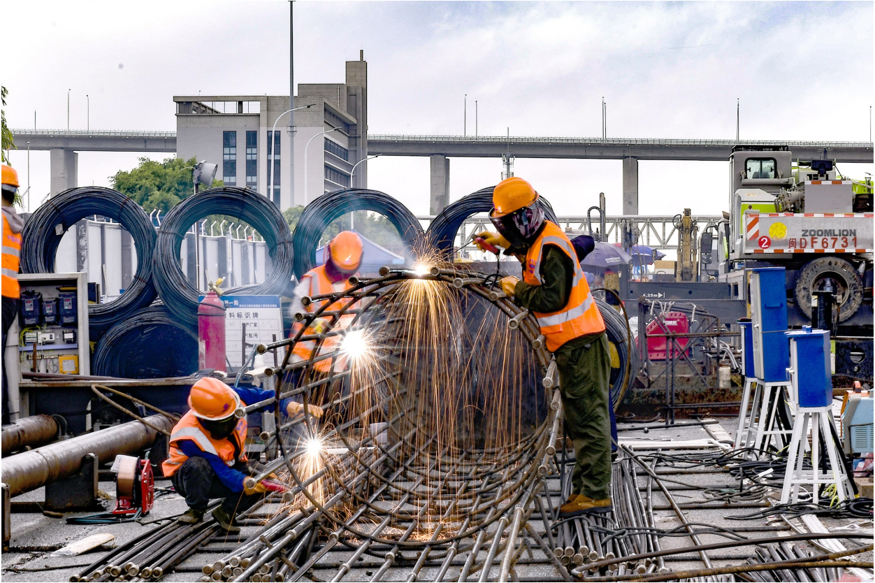
中铁一局厦门公司承建的厦门海沧区沧江路快速通道工程，是海沧港区重要的东西向集疏运干道。项目施工合同工期180天，施工产值
