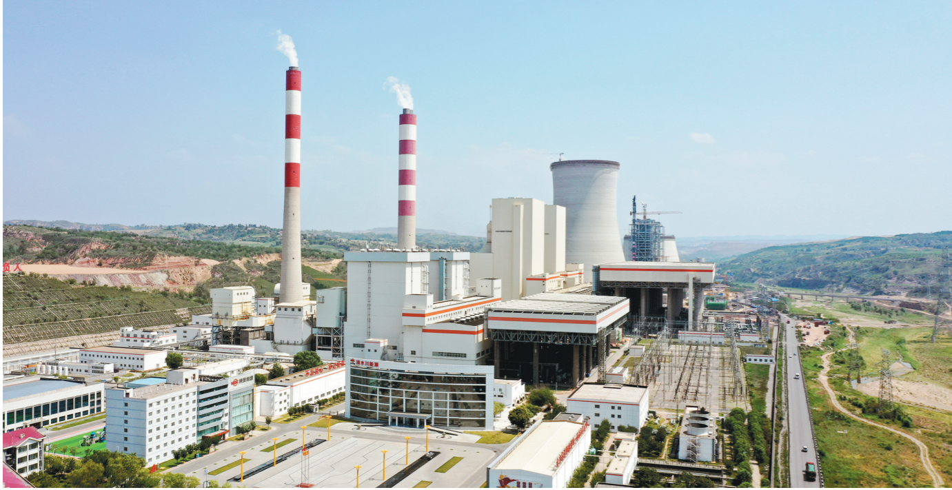
三期扩建工程现场(航拍)。陕西清水川能源股份有限公司煤电一体化电厂。本报记者 刘强 摄
