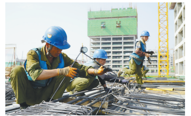
近日,陕建十一建集团所属的中国丝路科创谷起步区09单元项目、天地源云水天境项目一标段建安工程获评2022年度第一批西安建筑业绿色施工示范工程创建项目。图为中国丝路科创谷起步区09单元项目施工现场。 陈党通 杨玉晨 翁希 摄
