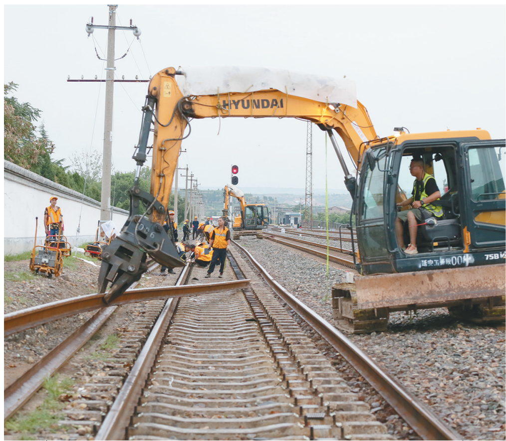
连日来,国铁西安局延安工务段集中对管内甘钟线黄陵站、富县站、坡底村站等18个站场29条股道进行无缝化升级改造作业,为保障汛期行车安全奠定基础。图为8月16日,该段职工在甘钟线坡底站利用挖掘机进行更换钢轨作业。 □李晓龙 摄
