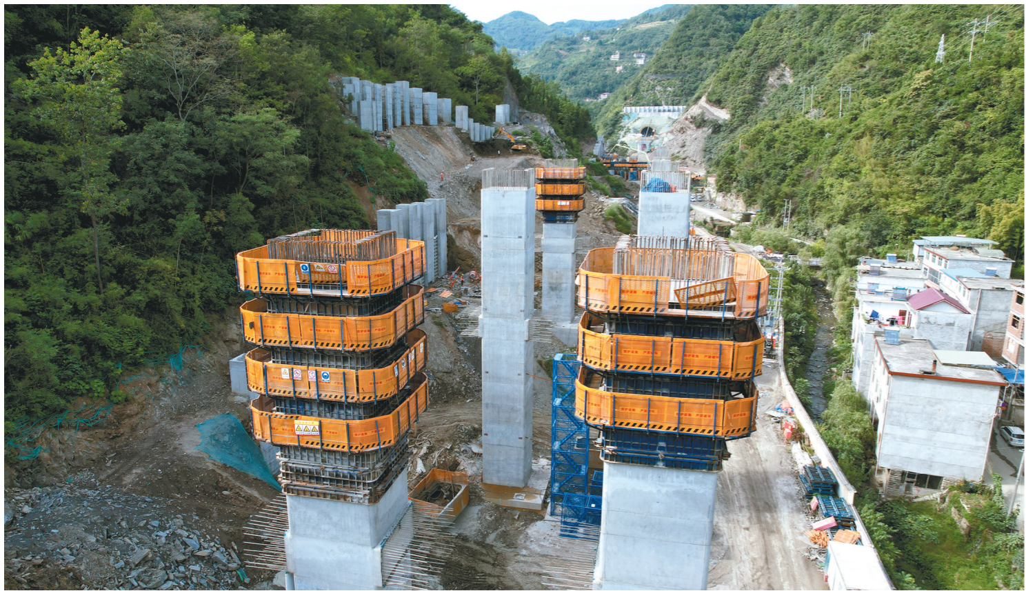
建设中的西康高铁桐木车站特大桥(9月6日摄,无人机照片)。西(安)(安)康高速铁路是国家中长期铁路网规划中“八纵八横”高速铁路网包(头)海
