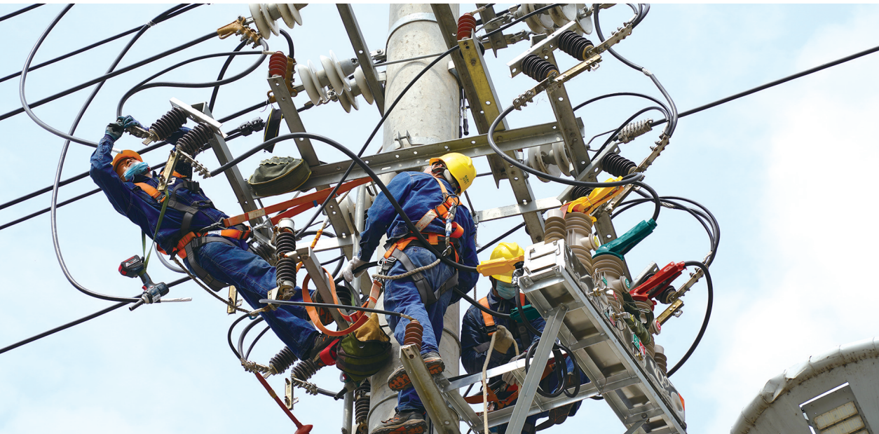
9月15日,国网山阳县供电公司开展“一停多用”综合检修,抽调基层供电所精干力量40余人,对10千伏136市区Ⅲ线进行综合检修。图为检修人员正在进行刀闸及避雷器更换作业。
