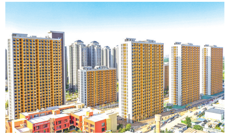
西安高新区长安通讯产业园公租房项目。
