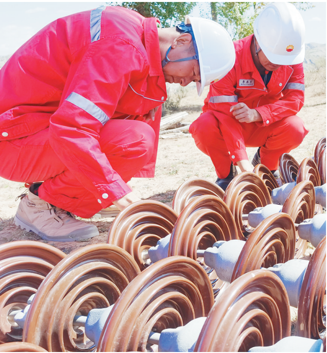
近期,靖边县杨木涧镇靖靖线104#—138#段几次出现瞬间接地故障,长庆油田清洁电力开发项目部电力大队立即采取地毯式巡视,最终将问题聚焦绝缘子。图为9月25日跟班作业人员现场对更换下的绝缘子进行检查。 □俱伟 摄
