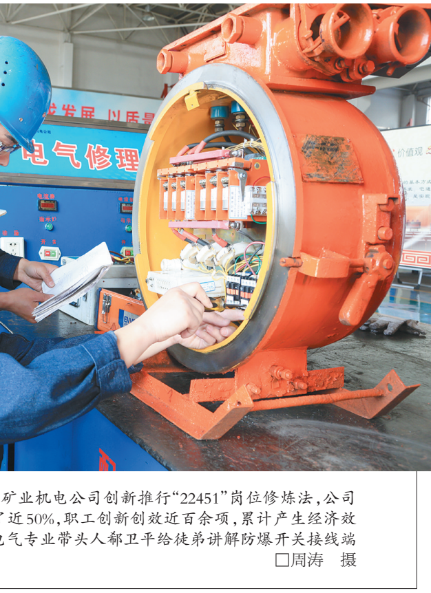
今年以来,黄陵矿业机电公司创新推行“22451”岗位修炼法,公司生产检修效率提升了近50%,职工创新创效近百余项,累计产生经济效益近千万元。图为电气专业带头人郝卫平给徒弟讲解防爆开关接线端子维修技术。 □周涛 摄
