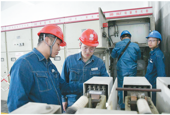
9月26日至27日凌晨,国网西安供电临潼公司对110千伏至王变电站进行“零点”紧急消缺,涉及110千伏至王变8条10千伏出线。经过6个多小时的艰苦奋战消除了隐患,27日早上8时恢复正常供电。 □潘世策 摄
