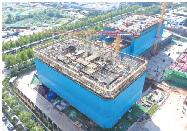
国庆节临近,中铁北京工程局国家超算西安中心二期项目部的300余名建设者坚守施工一线,全力推进项目建设。赵冠森 摄
