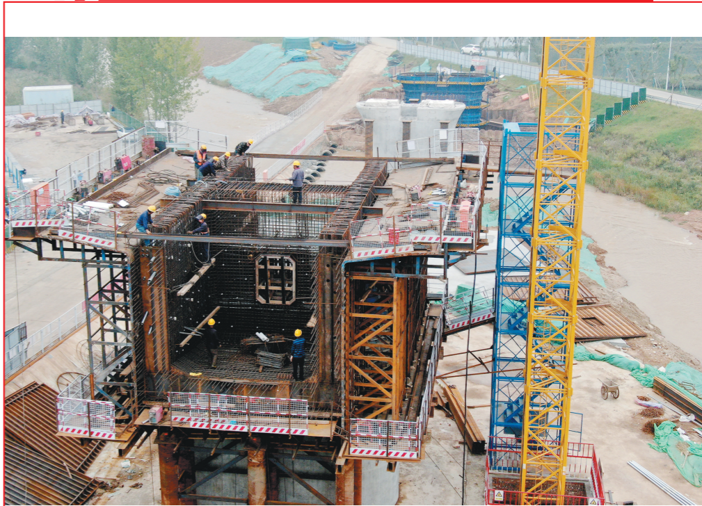
10月2日，中铁上海工程局施工人员在位于西安市的西(安)十(堰)高铁跨黄河连续梁0号块作业(无人机照片)。
