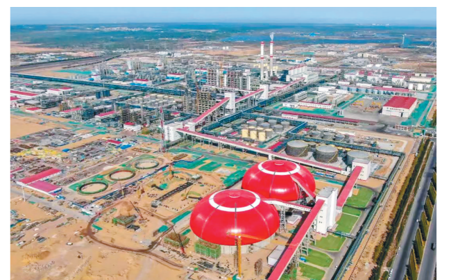
近日,由陕建安集团参建的榆林化学公司项目一阶段工程建成投产。该项目是全球在建最大煤化工项目,计划总投资约1250亿元,年转化煤炭约2400万吨。图为该项目鸟瞰。帖英杰 王诗萌 摄
