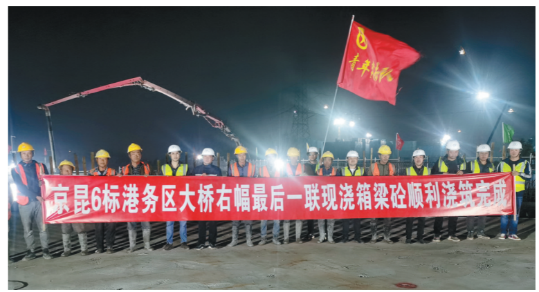
近日,(北)京昆(明)高速改扩建项目六标段港务区大桥右幅最后一联重318吨、长80.3米的现浇箱梁顺利浇筑完成。自该桥架梁施工以来,陕西交控集团京昆改扩建管理处联合总监办多次指导项目建设,确保箱梁浇筑安全准确无偏差。本报记者 郝佳伟 摄
