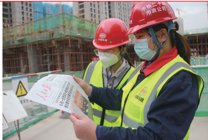
近日,中铁二十局市政公司结合实际制订学习方案,确保党的二十大精神进基层、进班组、进工地。图为职工在施工现场学习党的二十大精神。许岗 摄
