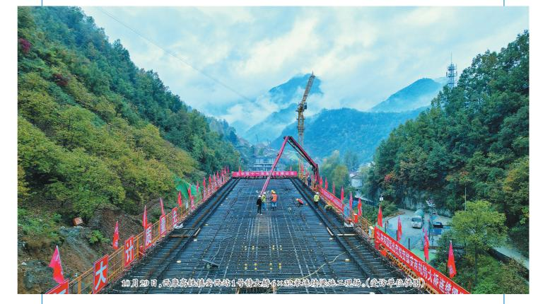
本报讯(记者 鲜康)记者从国铁西安局获悉,10月 29日9时,经过8个小时连续奋战,西康高铁镇安西站1 号特大桥6×32米连续梁浇筑完成。这是西康高铁全线 完成的第一联连续梁,也是全线孔跨数最多的连续梁。
