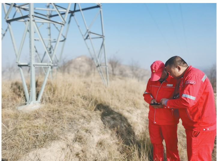
为提高线路巡视的高质量,长庆油田清洁电力开发项目部靖边电力大队选派了一批技术骨干学习无人机电操作。图为11月5日工作人员利用新配发的线路巡视终端现场解决疑难问题。
