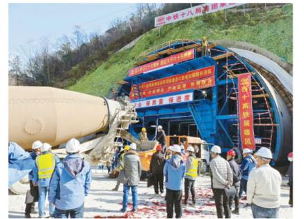
11月14日,西安至十堰高铁骆驼山隧道进口启动首板衬砌混凝土浇筑施工,这是全线最大断面隧道,断面面积达314平方米,也是目前在建高铁中穿越秦岭山脉的第二大断面隧道,标志着西十高铁建设进度进一步加快。 本报记者 鲜康 摄
