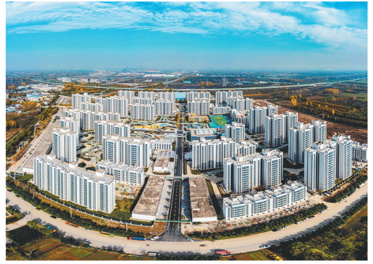
11月14日,航拍由中天西北集团总承包施工的西安市滨镇保障性租赁住房提升改造项目。该项目是西安市重点民生项目,总建筑面积约57.79万平方米,已建成区共有住宅36栋、商业建筑11栋、公共建筑5栋。预计提升改造后,可提供保障性租赁住房5238套。 袁景智 摄
