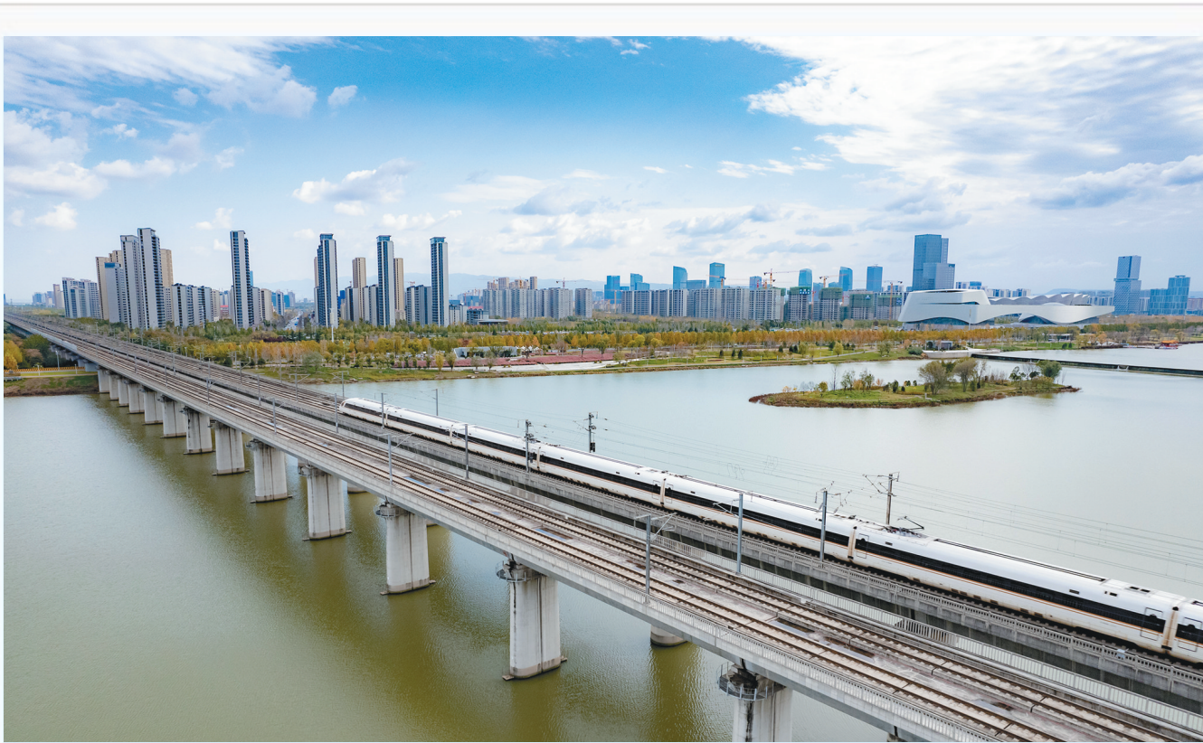
连日来,陕西多地气温下降,昼夜温差日渐加大。国铁西安局西安机务段坚持“安全第一”的原则,要求动车组司机严格落实季节性行车措施,确保每趟列车运行安全平稳正点。
