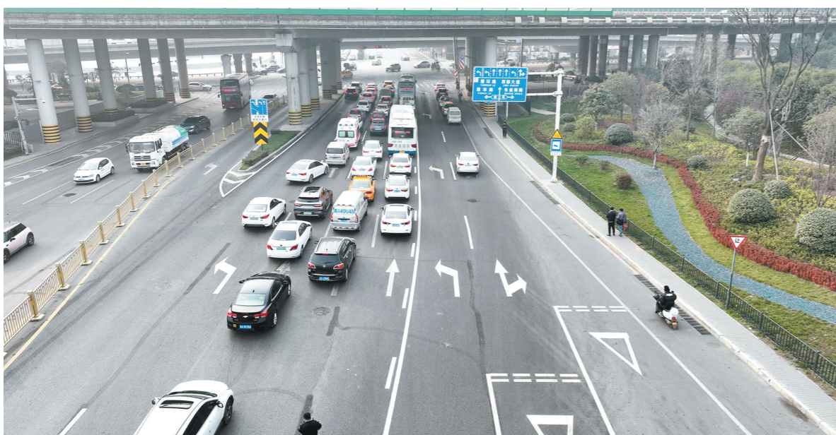
12月7日,在西安南三环与长安南路交叉口北进口道,西安公安交警首次实施的“固定式借道左转+左转右置+主干道优先”的交通微改造组合,正式启用,高峰时段左转弯车辆每小时可多走200余辆车。图为改造后增加了最左侧的固定式借道左转弯道。张佳 摄
