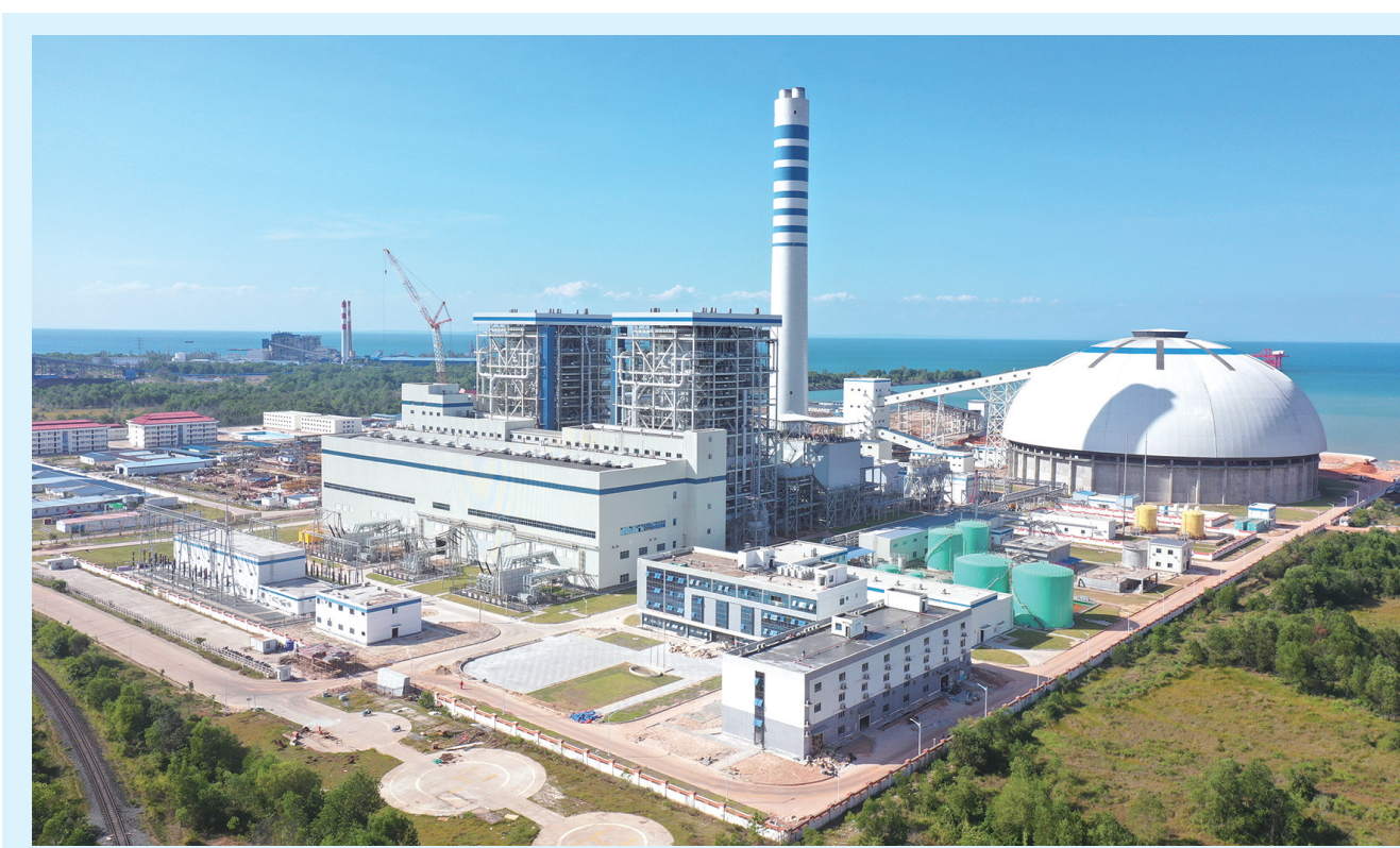
这是12月16日拍摄的柬埔寨西哈努克港燃煤电站(无人机照片)。华电海外投资有限公司投资运营的柬埔寨西哈努克港燃煤电站(华电西港项目)2号机组16日顺利通过试运行,正式投产发电,标志着柬埔寨总装机容量最大的发电项目建成投产。 □新华社发 李欣琳 摄
