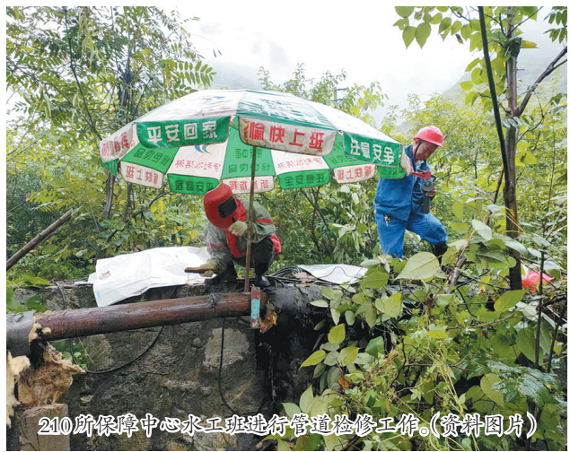
210所保障中心水工班进行管道检修工作。(资料图片)
