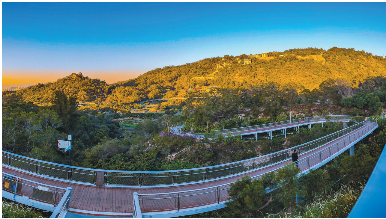
由中铁一局厦门公司承建的厦门东坪山健康步道项目近日已全面建成。该项目长度约7.3公里,步道净宽2.8米。工程包含路基、桥梁、景观园建、浇灌、绿化、电气、管线、智能化、配套土建、配套安装等10个单项工程。王冬生 摄
