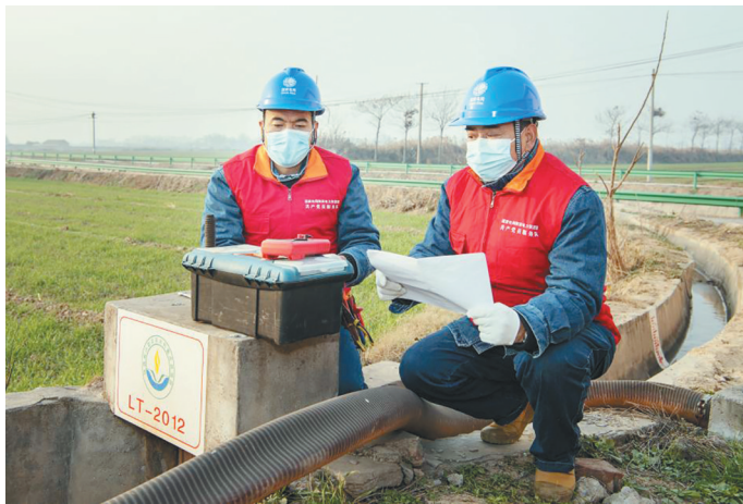
图为国家电网西安市临潼区供电公司工作人员正在麦田边测试灌溉设备。(受访者供图)
