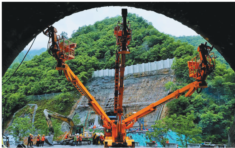
这是西康高铁林家村隧道建设现场。 (资料图 铁一院集团有限公司供)
