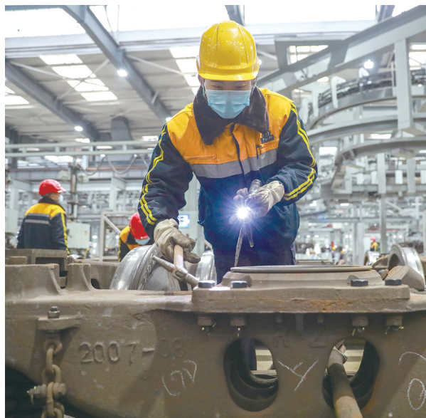
面对即将到来的春运,国铁西安局西安东车辆段严格落实车辆检修作业标准,加强对转向架、轮对等车辆关键部件的检修力度,为货物运输提供优质车源。图为职工正在进行转向架落成检查作业。
