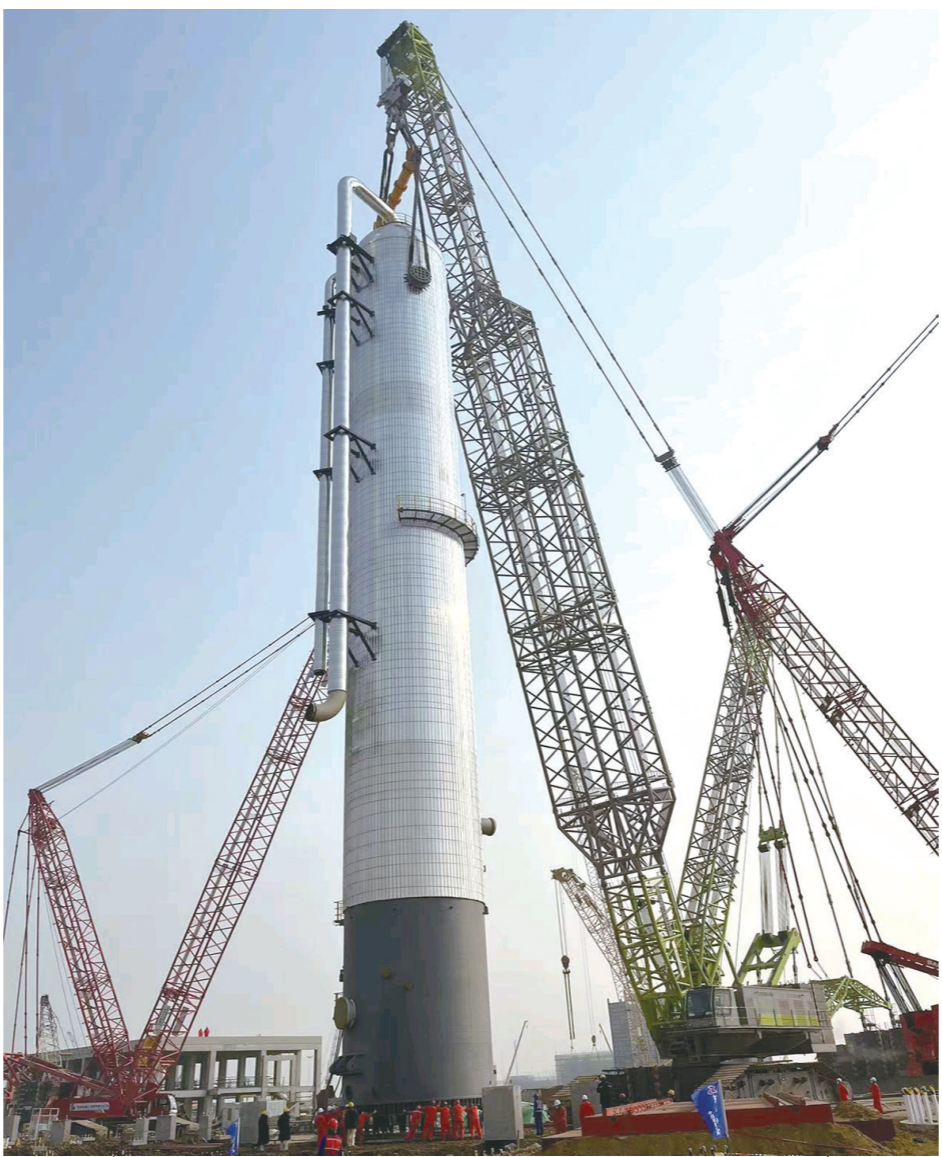
近日，陕西西建公司成功吊装山东裕龙石化裕龙岛炼化一体化项目(一期)1号150万吨/年乙烯装置精馏塔设备，为2023年项目掀起大干高潮奠定了良好基础。 □陈鹏 陈练斌 摄
