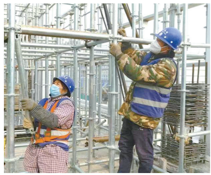
农民工在秦川工业母机项目施工。
