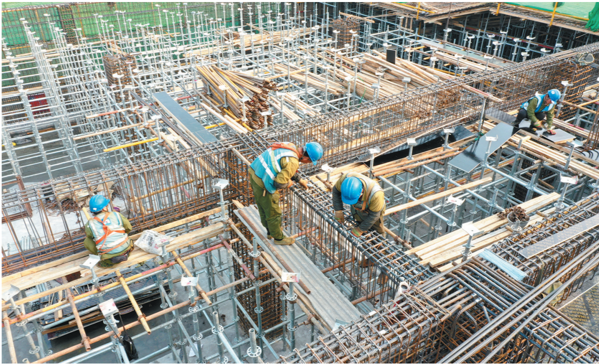
近期,陕建三建集团陕西文化艺术博物院项目一期掀起了春节前的施工生产高潮,现场各类施工作业人员超过300人。据了解,该项目
