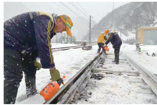
1月14日,国铁西安局安康工务段针对青岔、镇安等严寒降雪区段,对道岔转辙等重点部位进行清扫,确保春运期间安全畅通。张霖 摄
