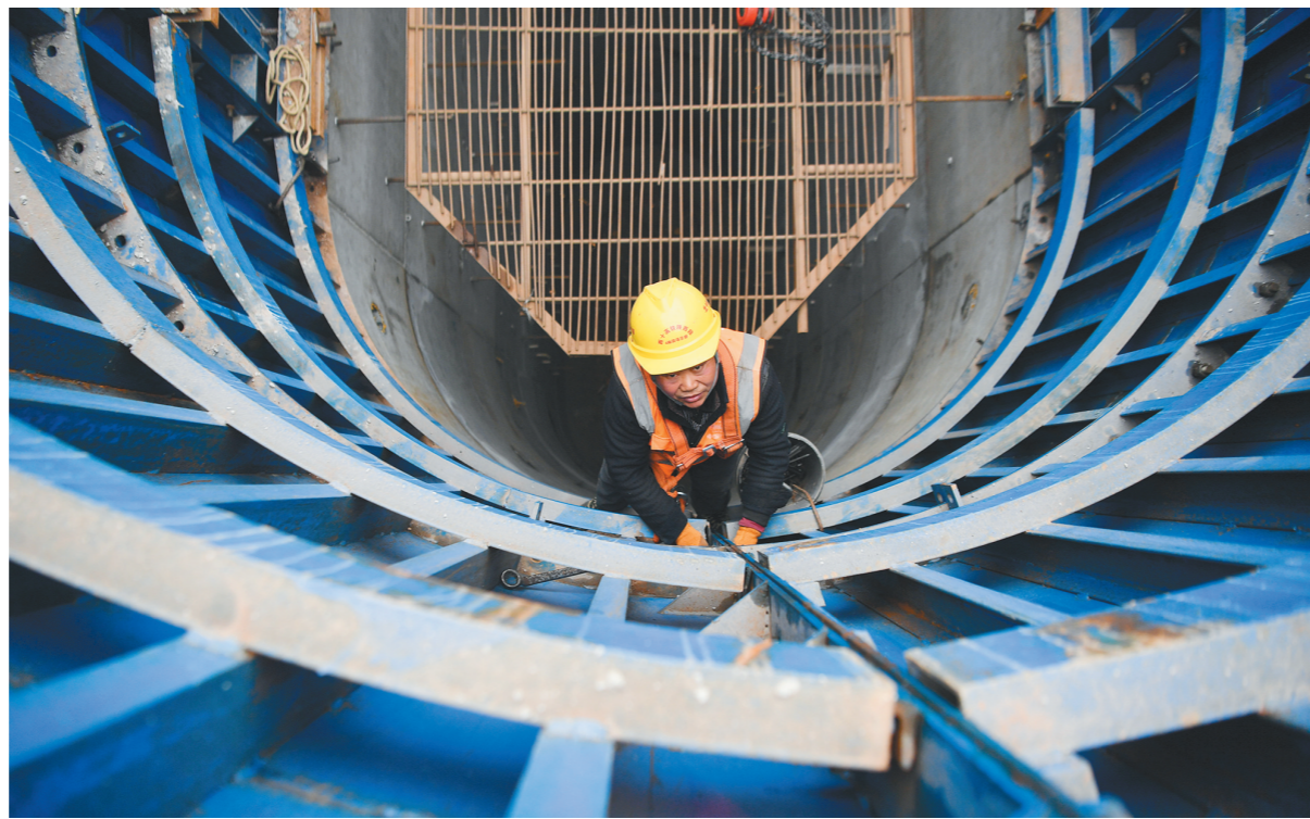
2月7日,中铁二十局工人在位于商洛市的西(安)十(堰)高铁南秦河特大桥施工现场作业。
