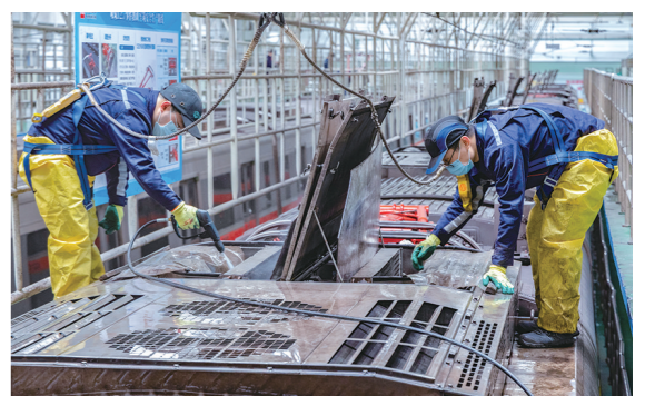
3月17日，西安市轨道集团车辆部门结合春季设备检修工作，对地铁列车空调机组内的通风冷凝部件进行冲洗清洁。图为工人正在车顶作业。 甘达 摄
