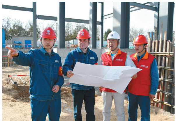
3月15日,国网西安供电公司到渭阳110千伏变电站施工现场开展“党建+安全”进工地活动,通过党员“双带头”等方式,进一步夯实安全生产基础,为变电站安全生产提质增效。 □潘世策 摄
