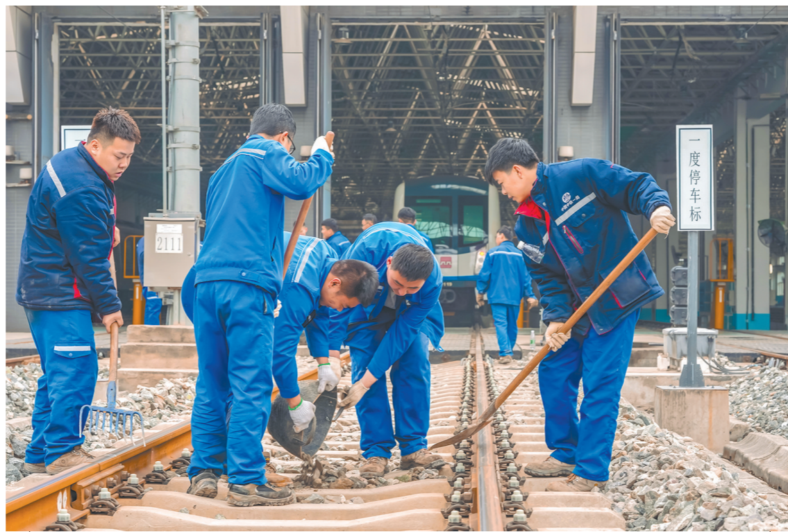
3月19日,西安轨道集团运营分公司轨道专业团队对关键设备进行集中隐患排查、整治,全面提升轨道设备质量,确保运行安全。图为工人正在整治道床病害。 □李嘉彬 摄
