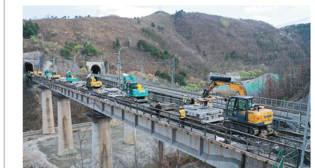
3月27日,西康铁路中修启动。国铁西安局安康工务段提前召开动员会,制订施工方案,确保施工顺利完成。图为该段职工对桥枕进行更换作业。张霖 摄
