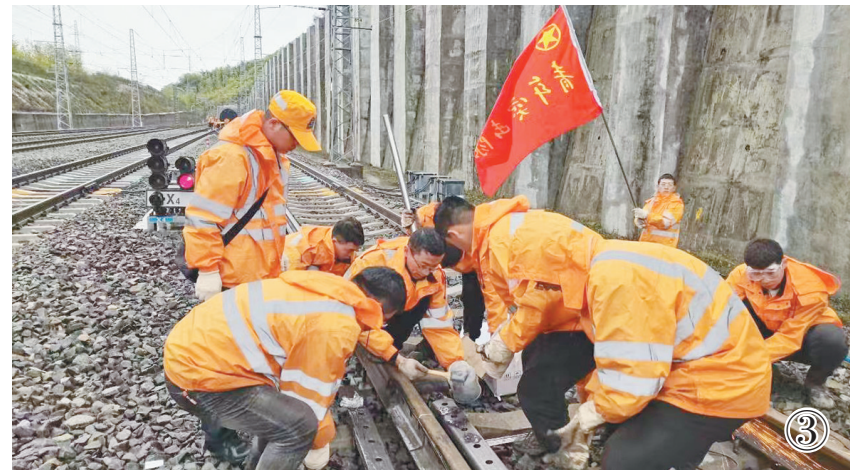
图①职工在打磨线路钢轨。
