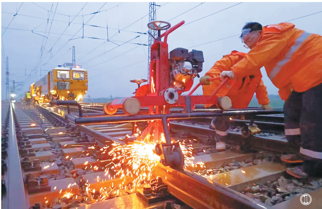
图①职工在打磨线路钢轨。
