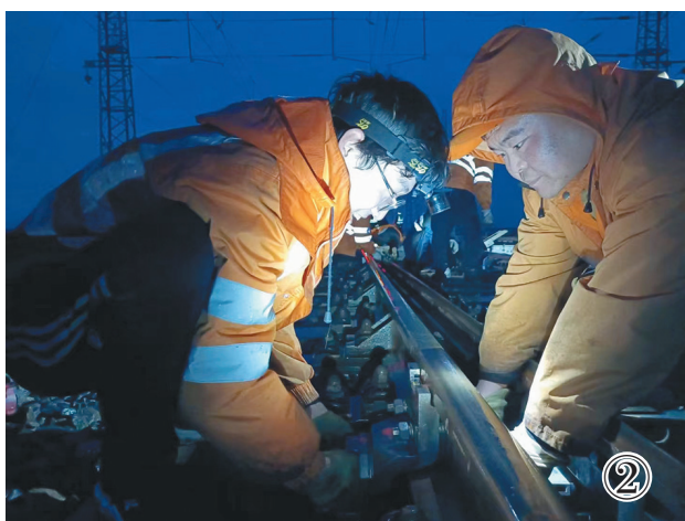
图①职工在打磨线路钢轨。
