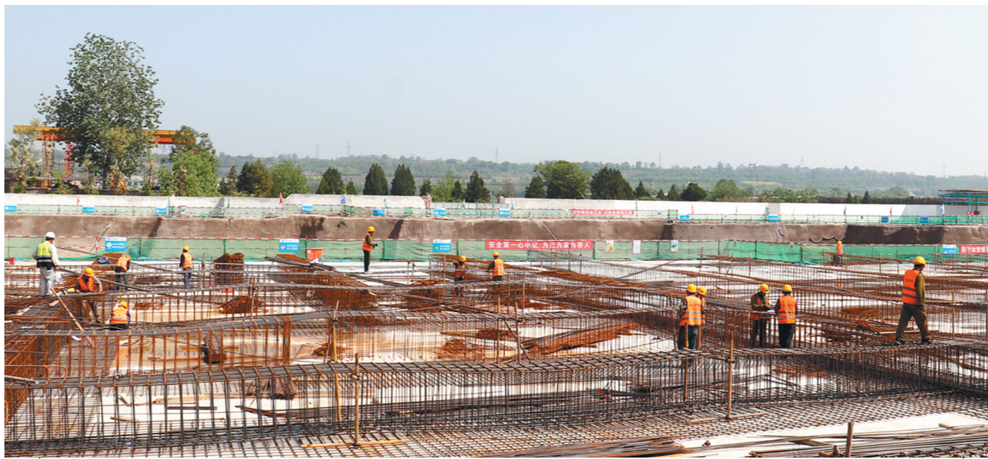
近日,中建七局四公司兴平市第二人民医院项目部为实现年底项目主体结构封顶,全体人员全力以赴推进项目建设“加速跑”。据悉,项目总投资5.92亿元,总建筑面积约7.9万平方米,设置床位500张,作为兴平市重大民生工程,建成后将进一步完善兴平市县域医疗卫生服务体系。图为建筑工人正在绑扎钢筋。 □周昊 摄
