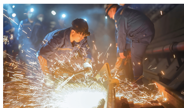
5月6日,西安市轨道交通运营分公司轨道设备维修部门职工,对2号线航天城站至韦曲南站隧道区间损伤钢轨进行更换,织密安全生产防线。李嘉彬 摄
