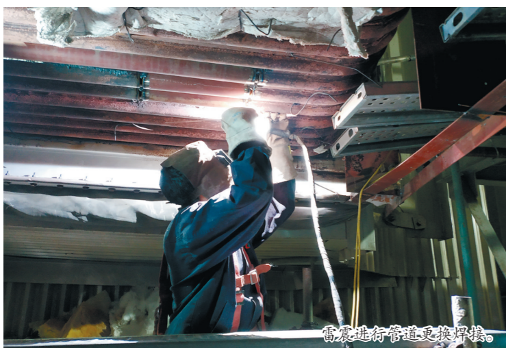
雷震进行管道更换焊接。
