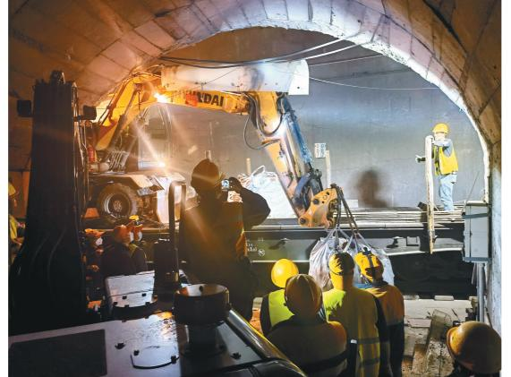
以来,国铁西 安局宝鸡工务 段集中力量对 永寿梁隧道基 础设备进行整 治,包括对隧 道基床下沉地 段进行注浆抬 升,对缺失、破 损侧沟盖板进 行更换,对铁 路线路尺寸进 行精调等。 □武建森 摄
