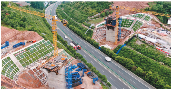
5月31日拍摄的西十高铁陕西段山阳跨桥银高速特大桥施工现场(无人机照片)。西十高铁开通后,对加强关中城市群与长江中游城市群联系等具有重要意义。 新华社记者 李一博 摄
