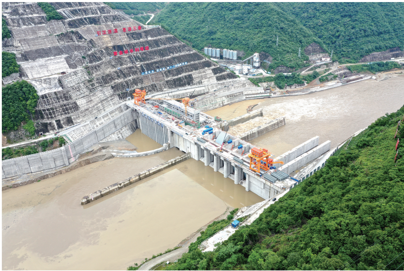
引汉济渭工程黄金峡水利枢纽。(受访者供图)
