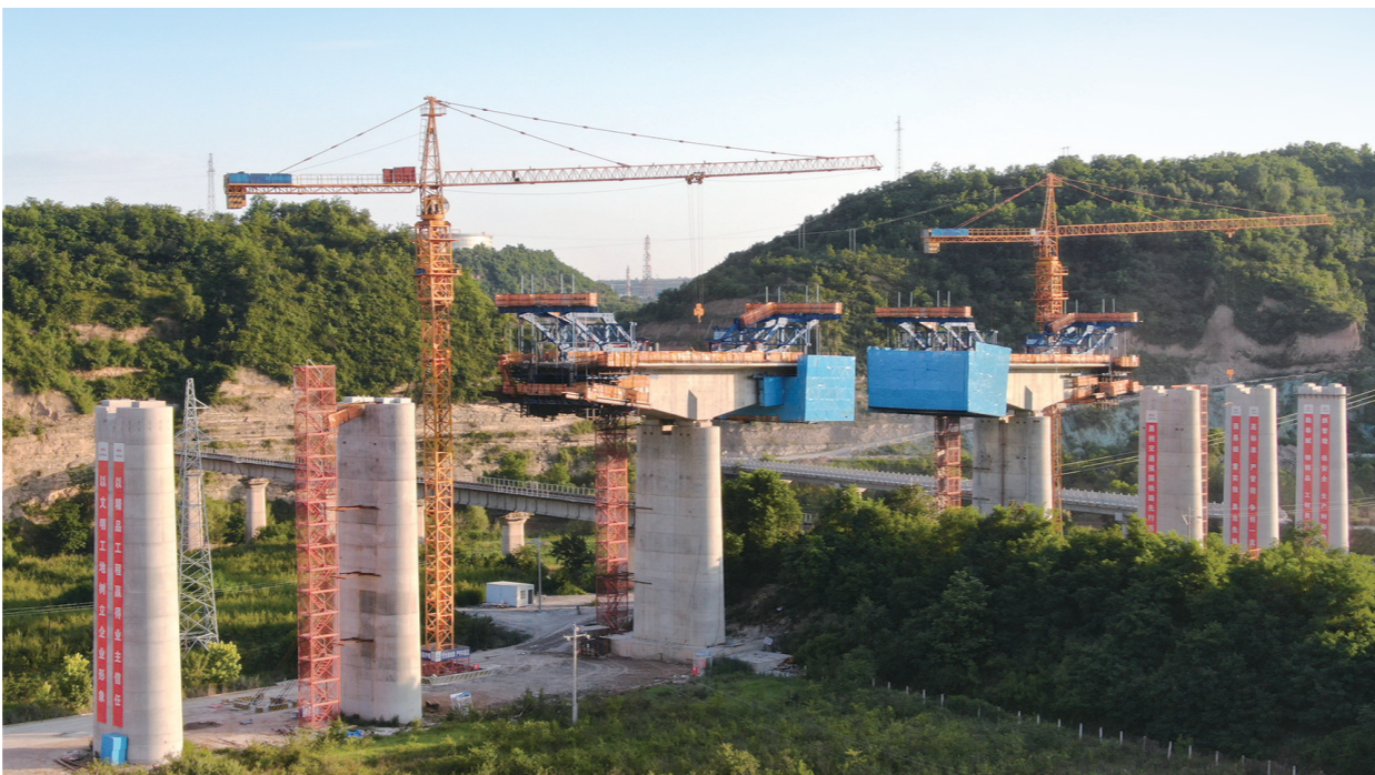
这是位于延安市洛川县的西延高铁XYZQ-8标段交口镇洛河特大桥施工现场(6月25日摄,无人机照片)。西延高铁是国家高速铁路网包(银)海高速铁路通道的重要组成部分。线路建成投入运营后,西安至延安的运行时间将从目前的2.5小时缩短至1小时左右。新华社记者 张博文 摄
