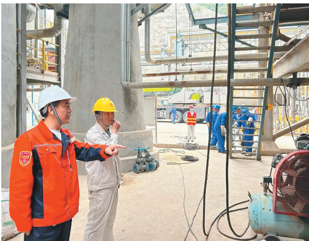
近日,延安炼油厂2023年装置大修检修如火如荼进行着。据悉,此次检修时间为5月20日至7月4日,历时45天,延安炼油厂全体干部职工和3500余名外协人员参加。图为检修现场。 □曹锋 摄
