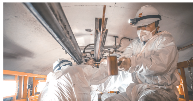
7月6日凌晨,西安市轨道交通集团运营分公司接触网工在5号线地铁隧道内作业。当日,该公司对省人民医院·黄雁村站至南稍门站下行接触线进行首次更换。 秦志红 摄
