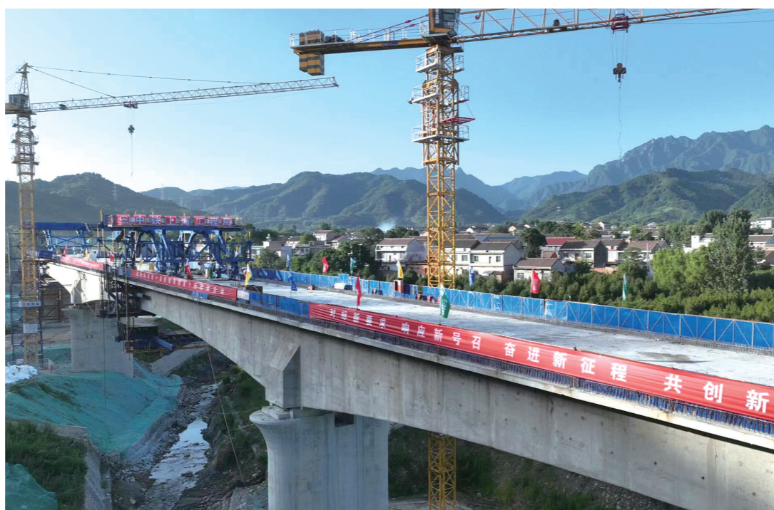
合龙施工现场。(受访者供图)
